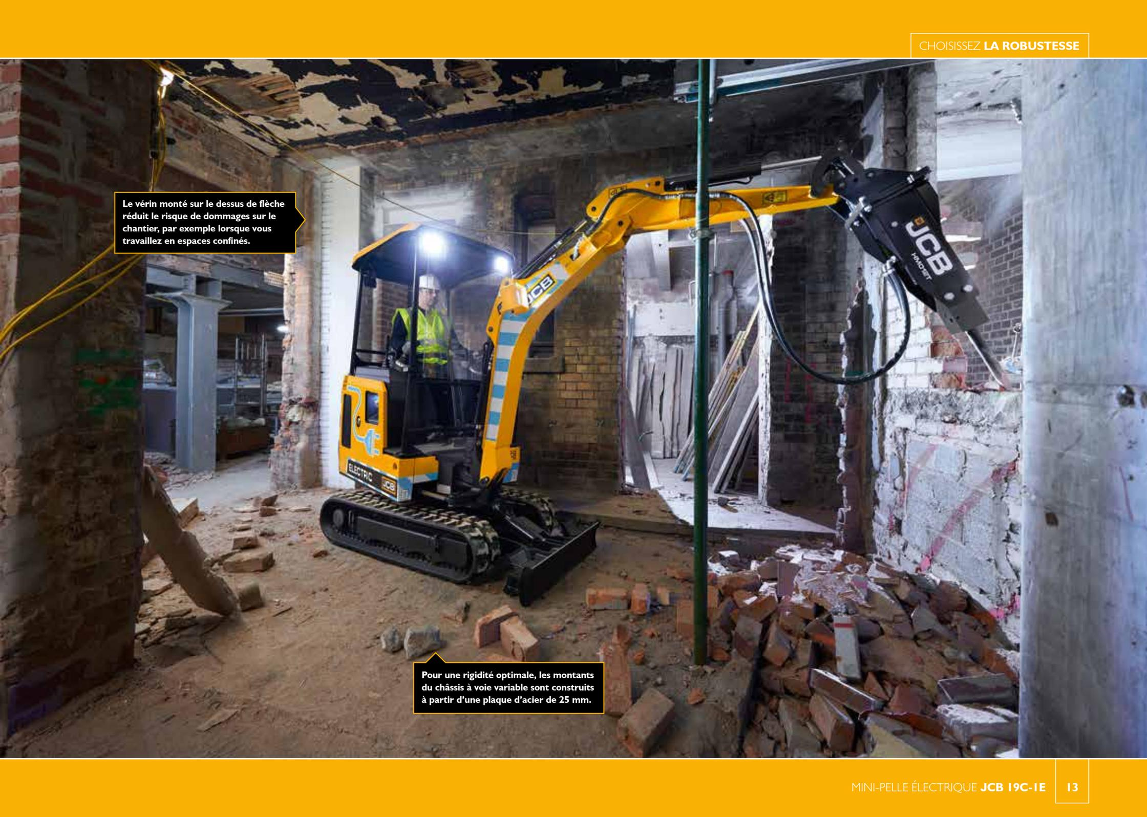
Le vérin monté sur le dessus de flèche réduit le risque de dommages sur le chantier, par exemple lorsque vous travaillez en espaces confinés.
